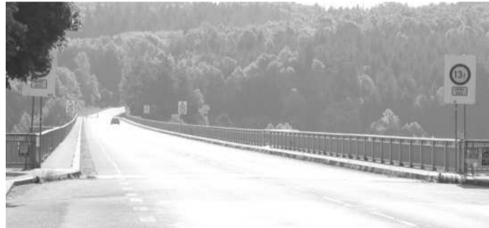
VE SMĚRU od Orlíku nad Vltavou nebylo poškození mostu tak vážné. Na most nesmí vozidla nad 13 tun od roku 2009.
